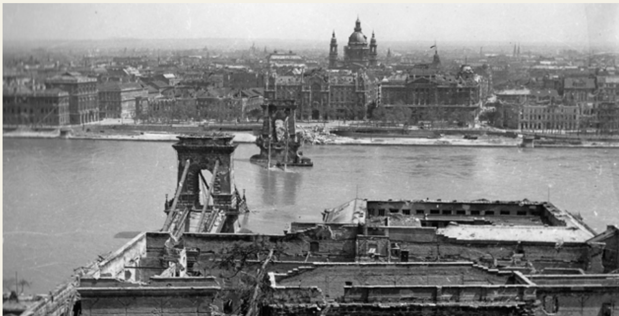
▲ El Puente de las Cadenas destruido, febrero 1945.
